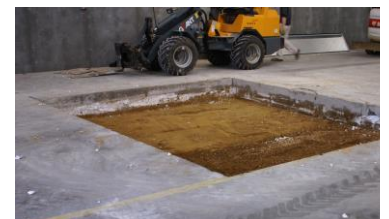
Klar til det nye fundament
