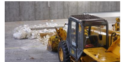
Der graves ud til nye fundamenter
